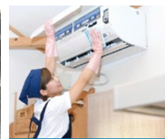
エアコン清掃の確認に
